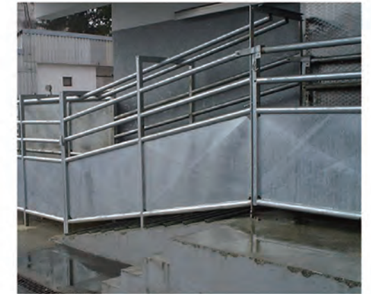
▲ Livestock runway ramp 牲畜斜坡通道
